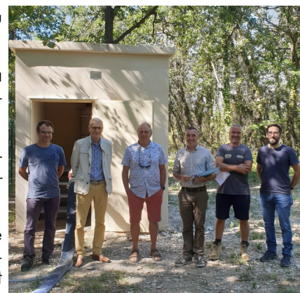
Réception travaux du 2ème captage
