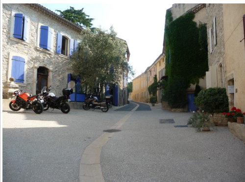
Portion de la rue du Tripot au niveau de la fontaine Avant - pendant et après
